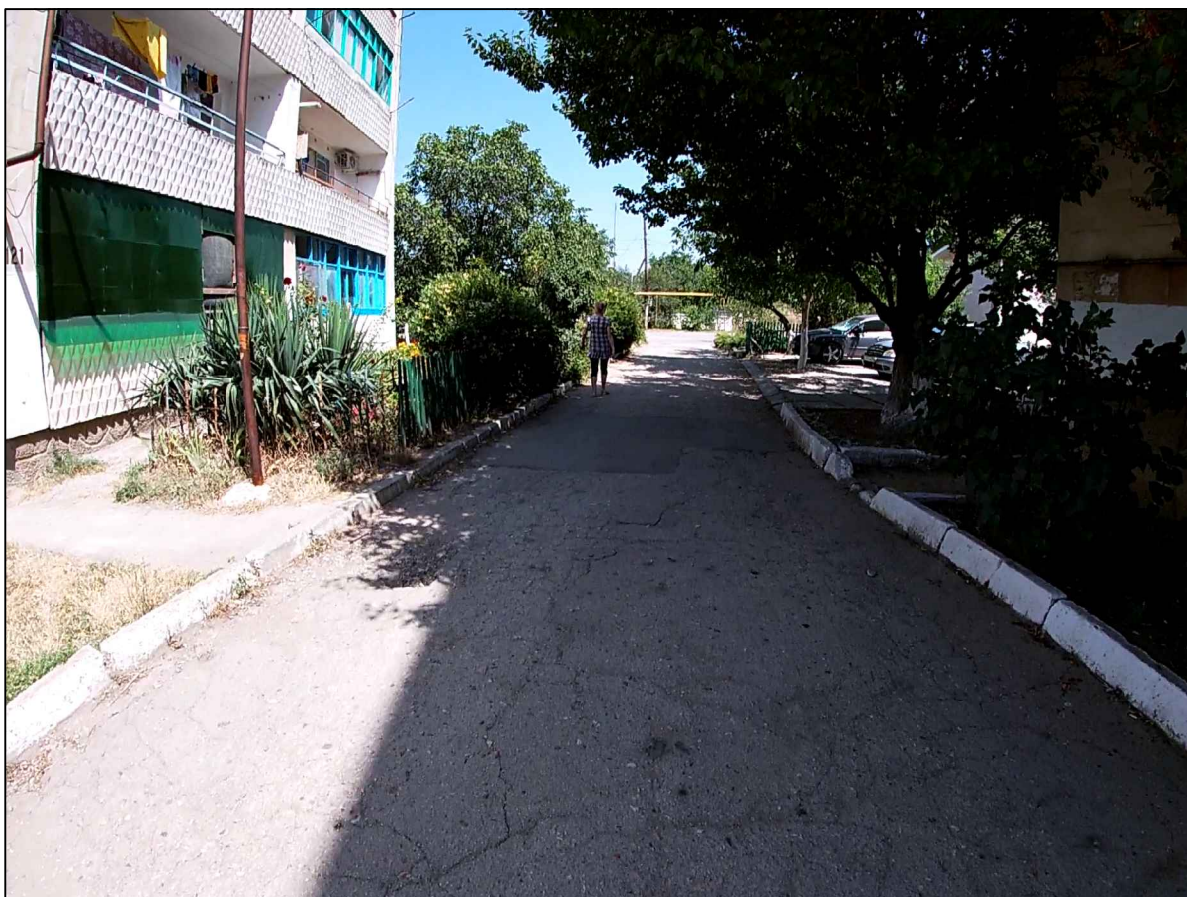
Вид на площадку благоустройства в сторону выезда на ул. Ленина.
