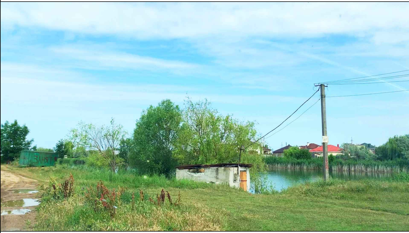
Вид на площадку благоустройства в месте размещения насосной станции полива.
